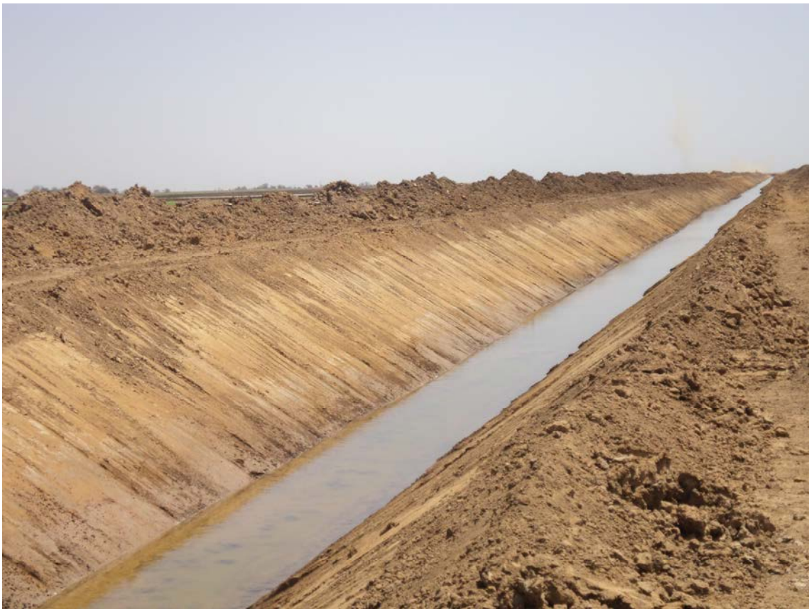
Photos 3 et 4 : Système de lutte contre la salinité par la remise en eau douce de parcelle rizicole en surface et la collecte des eaux salées souterraines dans des drains
