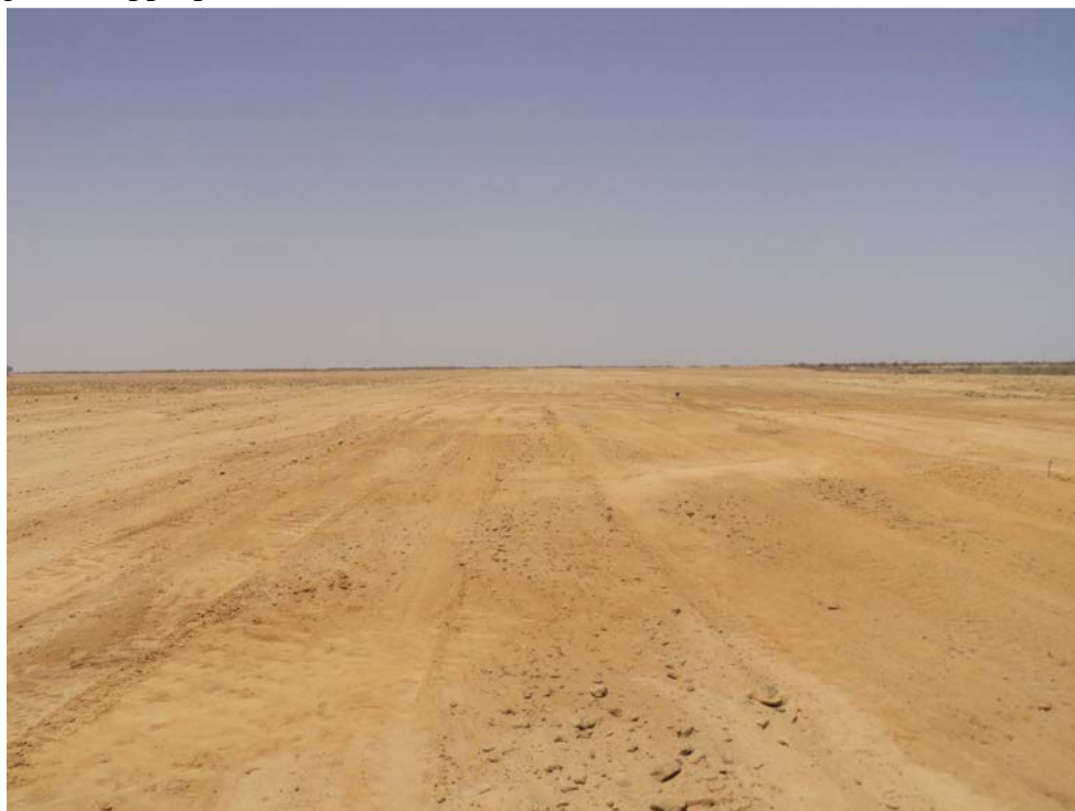
Photo 5 : site préparé pour l'aménagement de la future piste d'atterrissage
