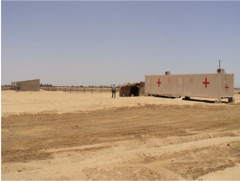
Photo 2 : Local provisoire de l'infirmerie, accessible aussi aux populations locales
